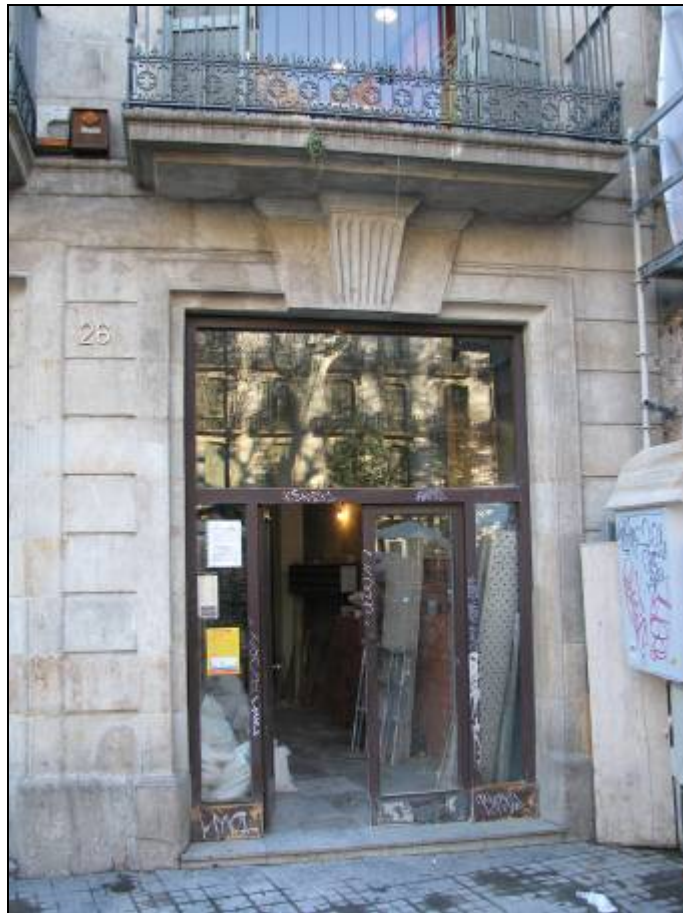
Foto 1. Aspecte exterior de la finca núm. 26 de la Rambla, Barcelona.
