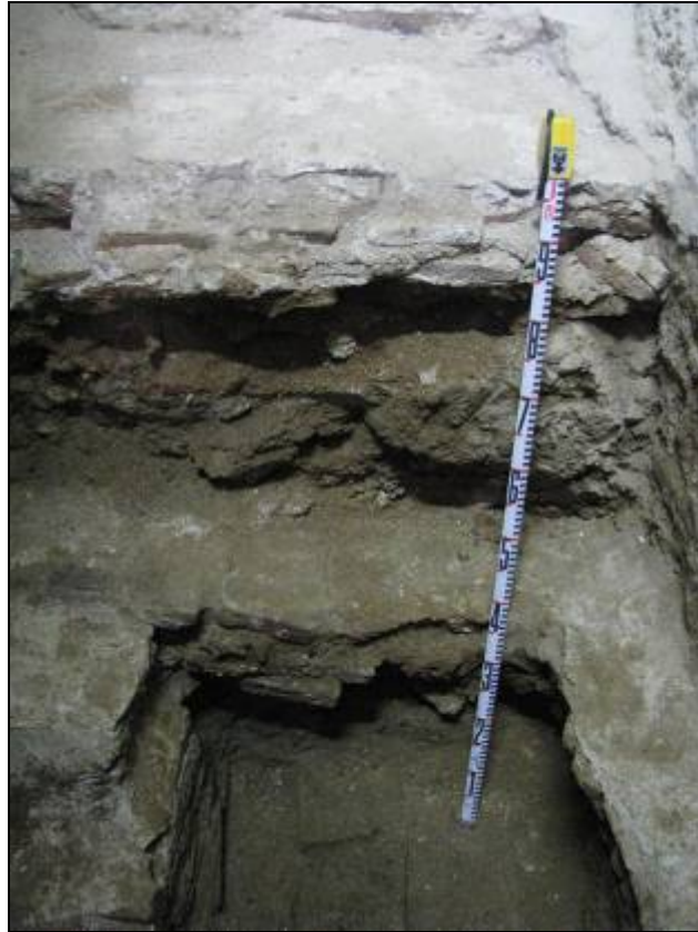
Foto 8. Detall de la riostra existent, la UE de terres i runa UE 1001 i la claveguera UE 1004.
