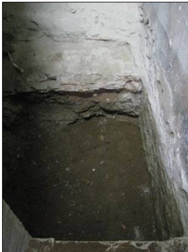
Foto 11. Estat final de l'estructura un cop coberta.
